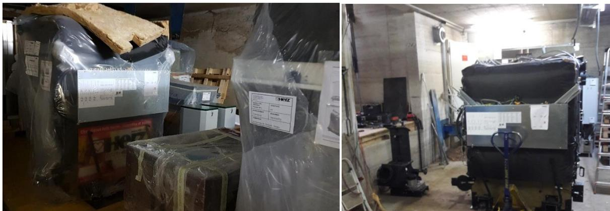
Figure 3 : Nouvelle chaudière à bois et son électrofiltre en cours de montage
